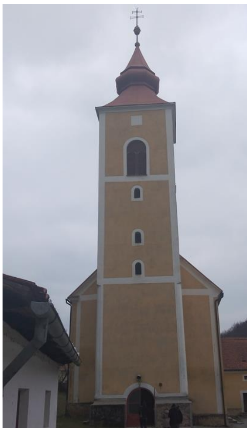
Slika 31. Značajno konstrukcijsko oštećenje
