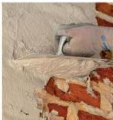
Žbukanje reparaturnim mortom
